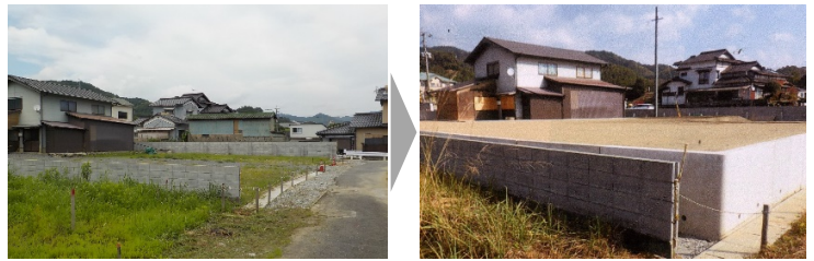
▲「宅地嵩上げ安全確保事業」による宅地嵩上げ（朝倉市）
