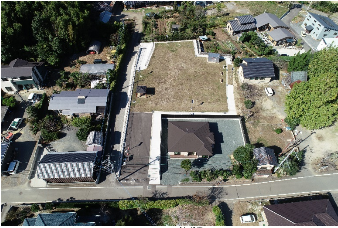
▲整備された避難地（ くししま 榊島地区緑地公園）
